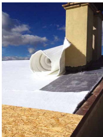
Coibentazione della copertura con materassino in aerogel
