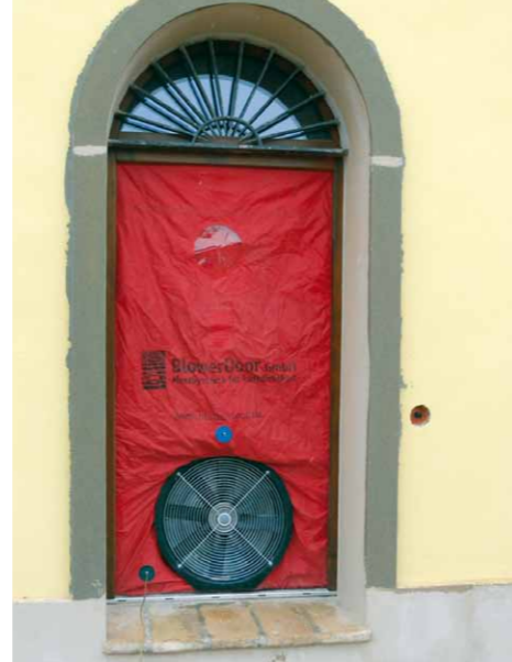
Test di Blower-Door
