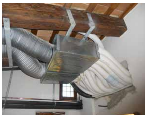
Casale del Lago, Certificato CasaClima R, progetto Ing. Sergio Pesaresi: collettori di distribuzione VMC
