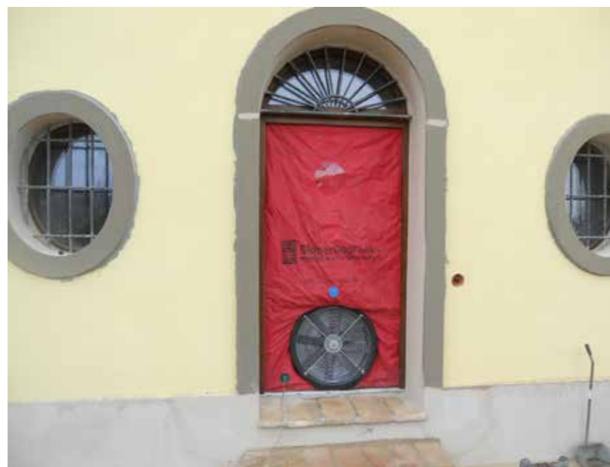
Casale del Lago, Certificato CasaClima R, progetto Ing. Sergio Pesaresi, blower door test - test di tenuta all'aria eseguito a conclusione dei lavori di ristrutturazione e comprova la qualità della posa in opera dell'involucro, dei serramenti e delle componenti impiantistiche
